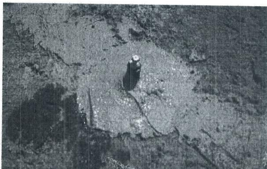
Рисунок 4.4 – Закрепление пакера и заделка трещины
